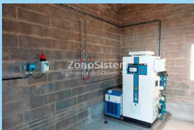
Sala técnica con generador de ozono balsa contaminada con mejillón cebra. Huesca.
