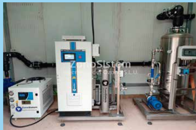
Ozonización de agua de aporte a balsas de riego. Murcia.
